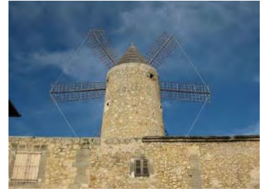
Façana carrer del molí foto 2014.
