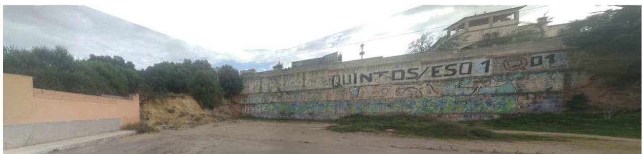
Vista dels murs de contenció de la plaça des Mercat
