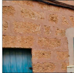
Carreus grans de marès amb morter de calç a les juntes
