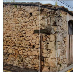
Paredat en verd amb les juntes resseguides amb morter
